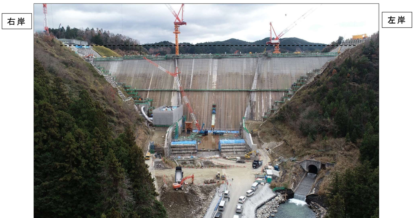
ダム下流より堤体を望む
