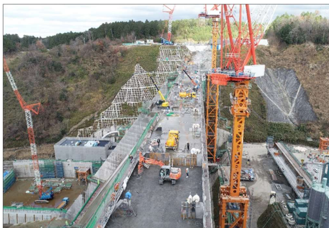
ダム左岸より堤体を望む
